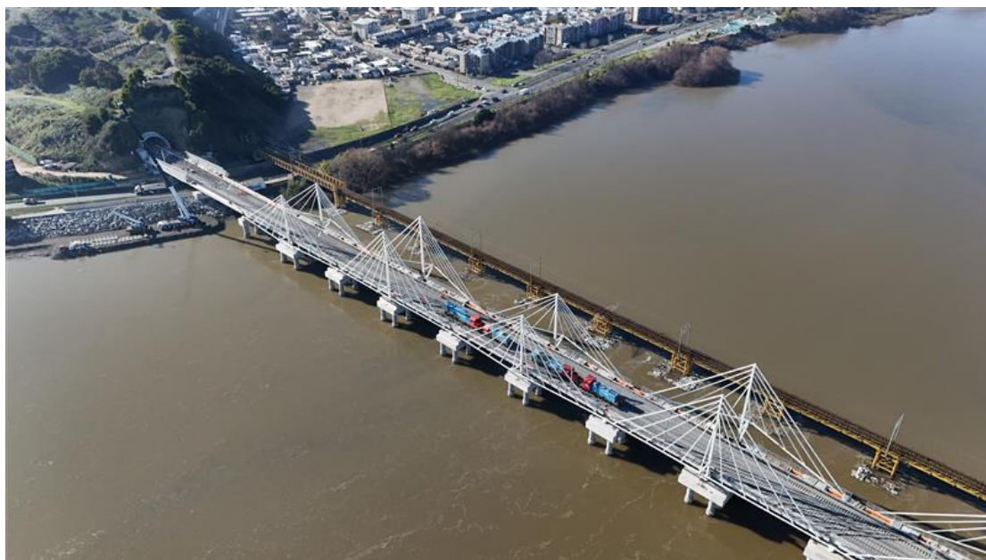
Puente ferroviario BÍO-BÍO
