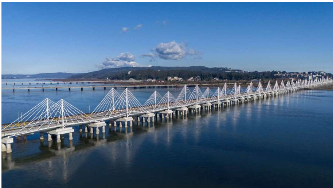
Puente ferroviario BÍO-BÍO
